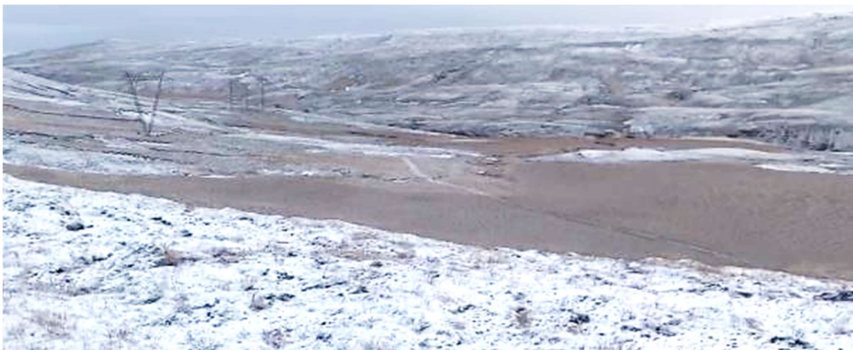
MYND 4.4 Horft frá framkvæmdasvæðinu til austur eftir Búrfellslínu 3 að vetri til. Á myndinni sést vegslóðinn sem tengir línuvegi Landsnets sem jarðstrengurinn verður plægður í. Myndin er skjáskot úr myndbandi.
