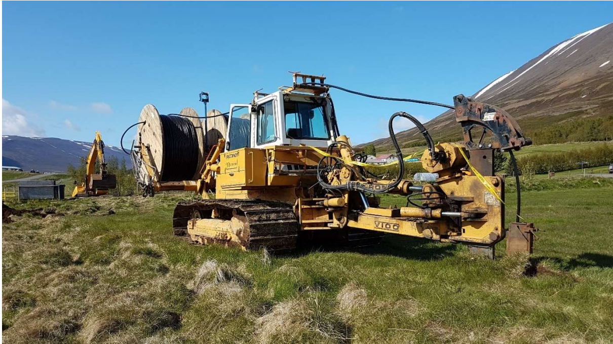
MYND 3.8 Plæging á einum 11 kV jarðstreng líkt og í tilviki jarðvarmavirkjunar á Folaldahálsi.
